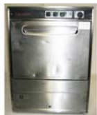
4.07 Spülmaschine FC54, Frontlader 230V/3,7kW
